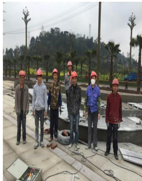
金辉国际酒店铺装班前会
